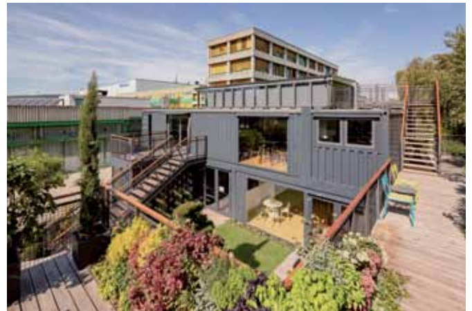
Das beengte Areal, umgeben von alten Unternehmensgebäuden und Baumbestand, stellte eine besondere Herausforderung an den Maschineneinsatz.
