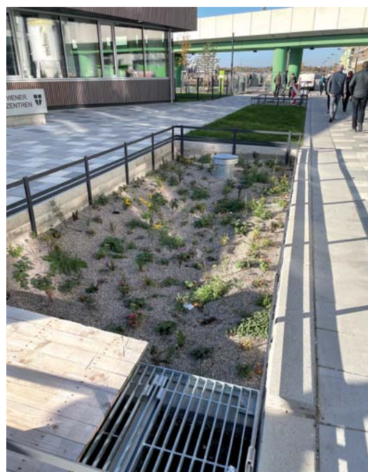
Eine Exkursion führte in die Seestadt Aspern vor den Toren der Stadt Wien, wo das Schwammstadtprinzip erläutert und die Erstellung der Baumgruben mit dem Regenwassermanagement in der Praxis gezeigt wurde.
