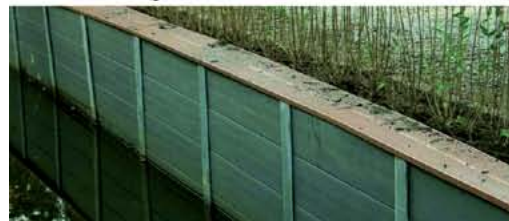
TRIMAX als Uferbefestigung
