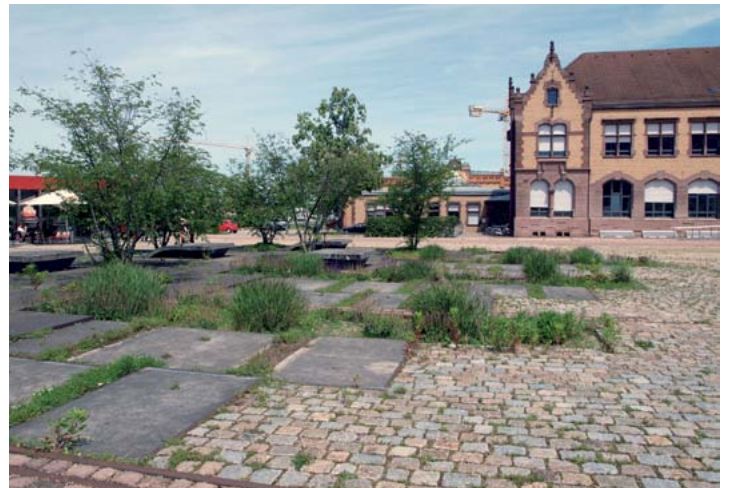
Versickerungsmulden auf dem Zollhallenplatz in Freiburg.
