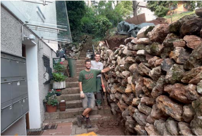
Ökologischer, Ressourcen sparender Mauerbau – Steckmauer
