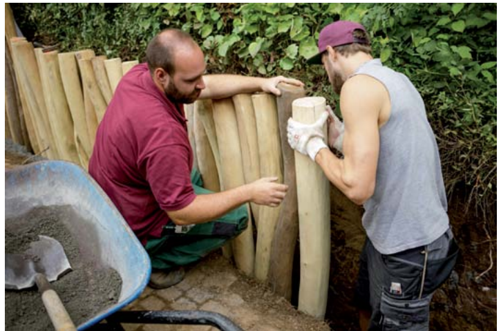
Spielgärten - Einbau Robinienpalisaden
