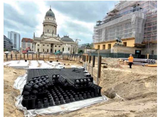
Entwässerungsrinnen und unterirdische Rigolensysteme von der ACO GmbH wurden 2024 auf dem Berliner Gendarmenmarkt verbaut.
